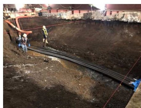
写真-3 仮中央排水管設置全景
