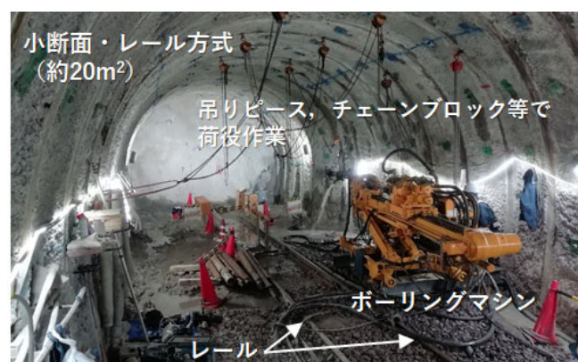
図-3 避難坑切羽とボーリングマシンの据付け状況
