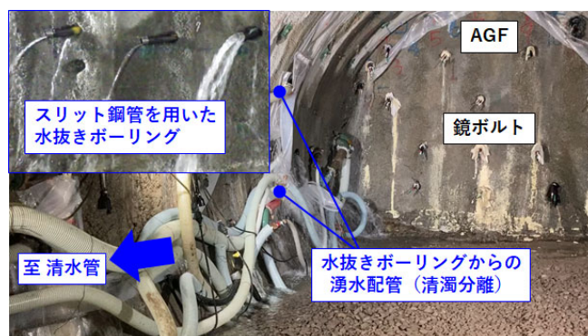
図-5 水抜きボーリングによる湧水対策
