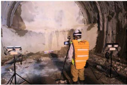
写真-2 切羽写真の撮影状況
