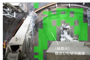
図-4 切羽鏡面の検出結果
