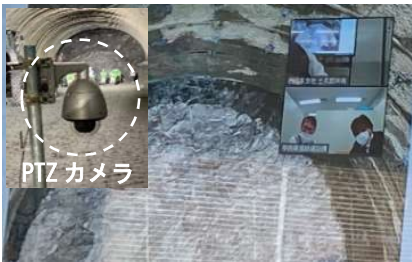
写真-1 遠隔臨場による岩判定
