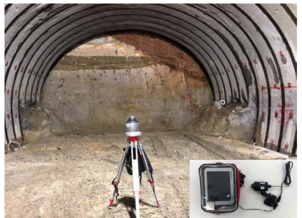
写真-2 切羽映像を撮影するカメラ (右下：ウェアラブルカメラ)
