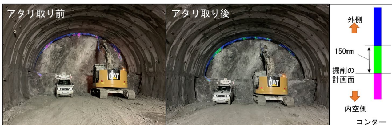
図4 掘削の過不足を示す画像の照射状況
