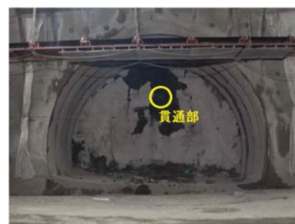
図-6 貫通後の切羽状況
