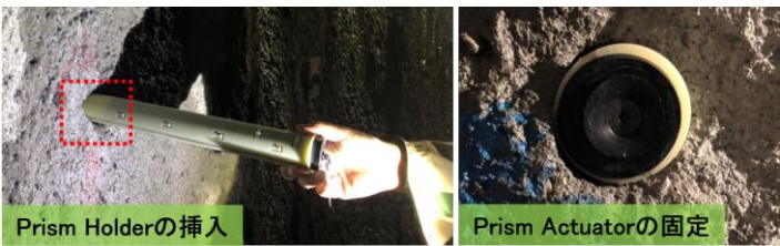
図-2 本機器の設置状況
