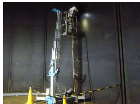
写真-2 除染状況
