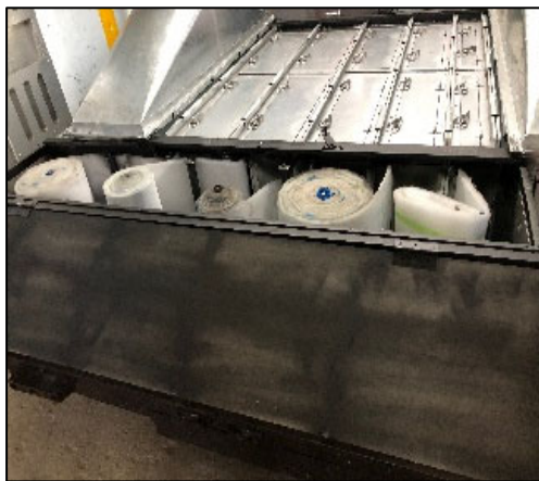
写真-5 リール式フィルタ装置
