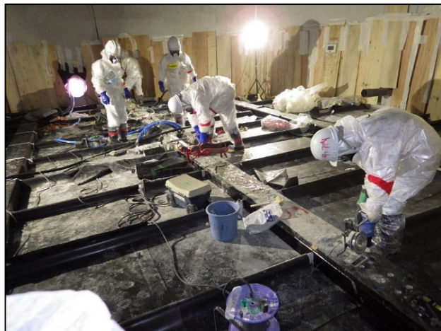
写真-1 フランジ型タンク内部解体作業状況
