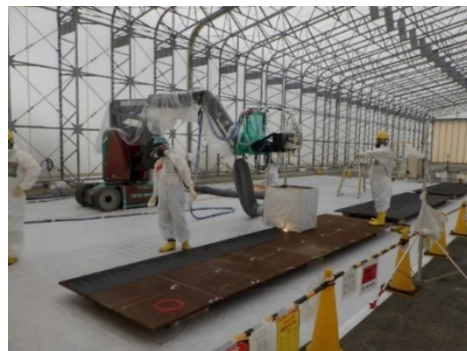
写真－1 レーザー照射状況
