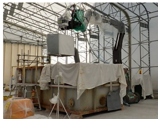
写真－2 レーザー照射状況
