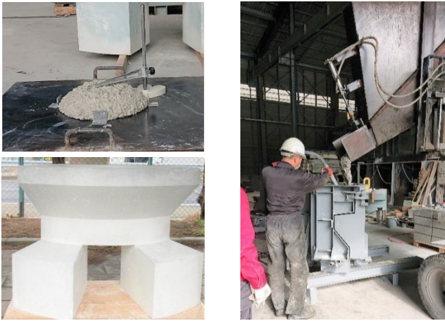
写真-2 ベンチの製造状況
