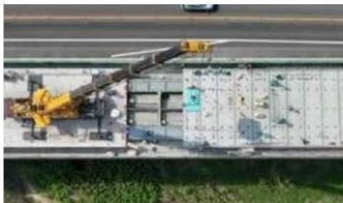
写真-1 夕張川橋床版取替
