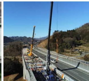
写真-2 中野橋床版取替
