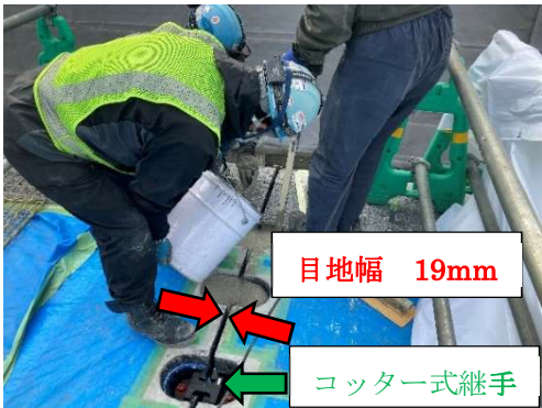
写真-1 目地材充填状況
