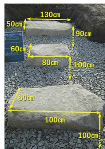
写真-1 硬岩設置状況
