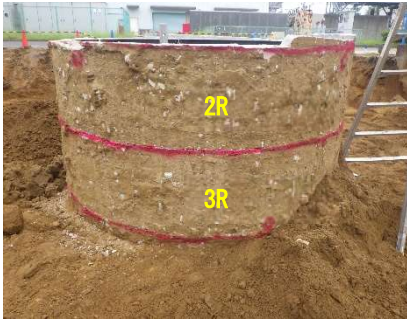
図-4 裏込め材充填状況
