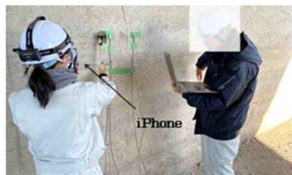
図-1 橋台における打音試験状況
