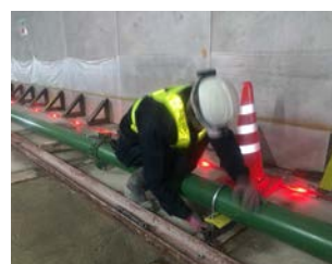
写真-4 金具固定補強
