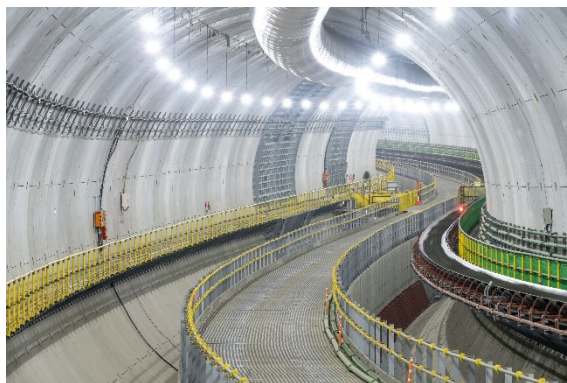
図-1 シールドトンネル坑内（3次元曲線部）
