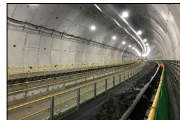
写真－1 トンネル坑内状況
