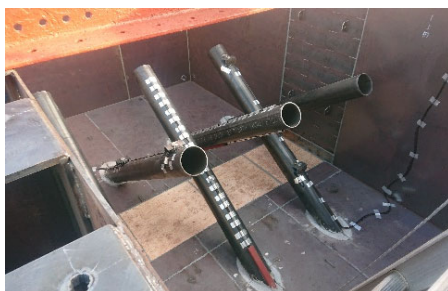
写真2 斜めパイプルーフ設置状況
