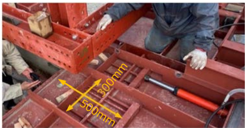
写真 3 スライド鋼板押し出し状況
