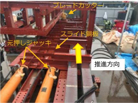
写真 1 推進実験状況
