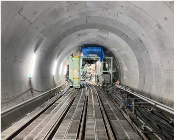
写真-3 組立完了(曲線区間)
