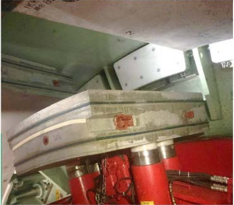
写真-2 セグメント組立状況
