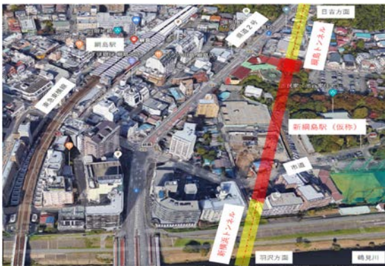
図-1 新綱島駅付近航空写真
