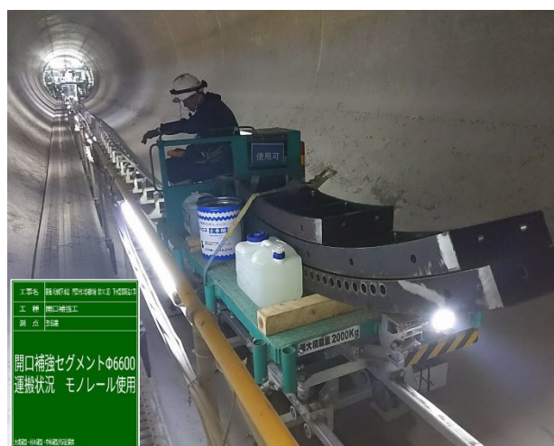
写真 2 モノレール資材運搬状況
