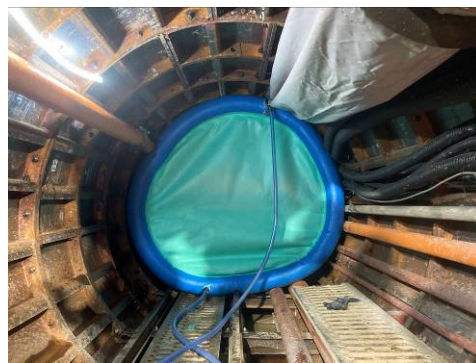
写真-2 止水バルーン膨張実験
