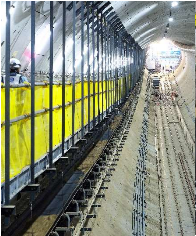
写真-1：連続ベルトコン
