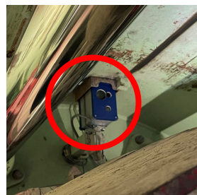
上部 機器設置状況
