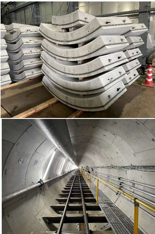
写真-1 コッタークイックジョイントセグメント
