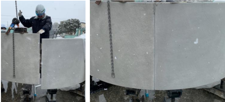
写真-4 組立試験状況 (S サイズ)
