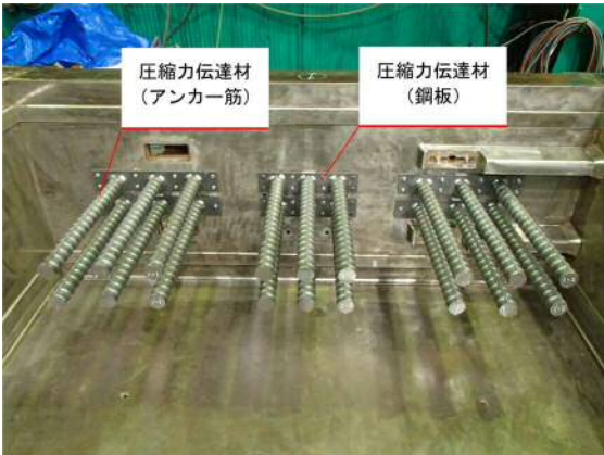
写真－3 圧縮力伝達材設置状況
