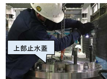
写真-4 シール押し付け状況
