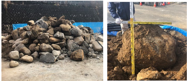
写真-1 立坑掘削時巨石状況
