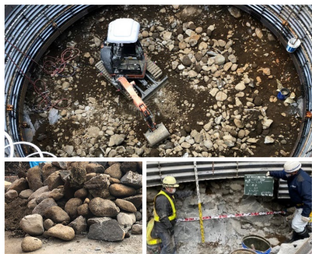
写真-1 立坑掘削状況
