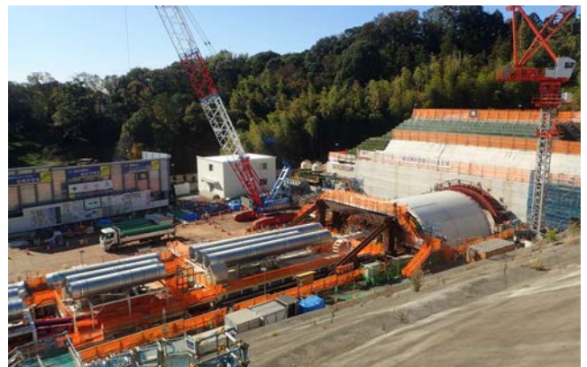
写真－1 2号機発進状況
