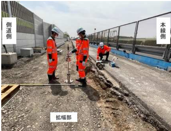
写真-1 狭小箇所での小型 FWD 計測状況
