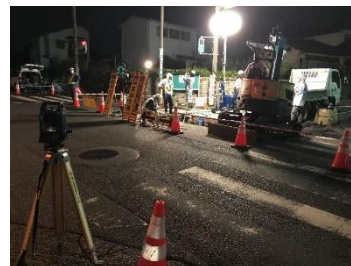
写真-1 試掘の状況
