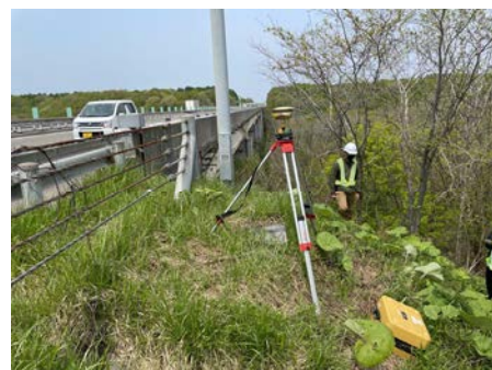
写真-3 基準点測量状況
