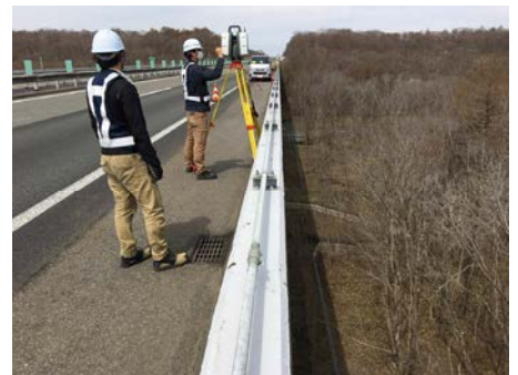
写真-1 地上レーザースキャナ測定
