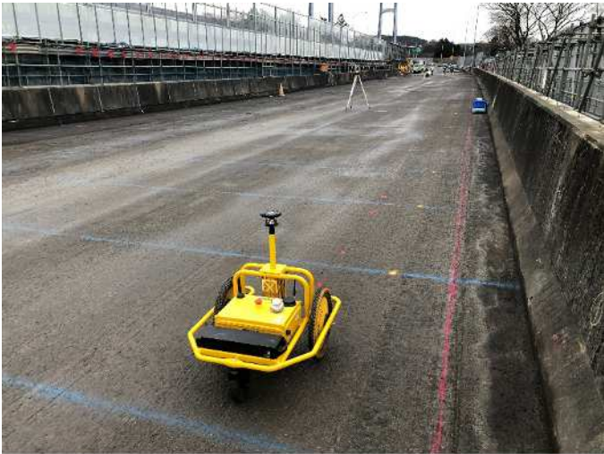
写真-3 マーキング状況 (自動追尾型トータルステーション)
