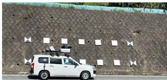
図-1 実験現場での MMS 計測状況
