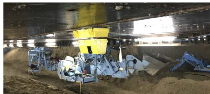
写真-1 大規模ニューマチックケーソン適用状況
