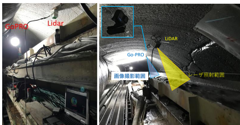
写真-1 TBM 坑内計測状況
