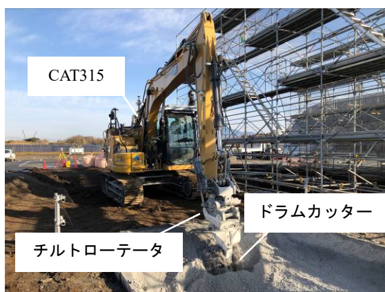
写真3 掘削作業の機械構成
