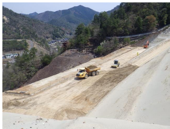
写真-2 盛土現場
