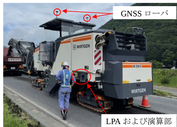
写真-1 施工状況
