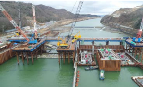
写真－1 新第二床固施工の状況
