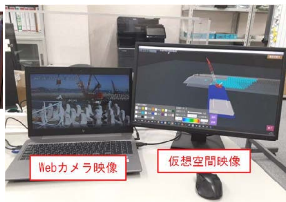
図-5 消波ブロック据付状況の遠隔管理
