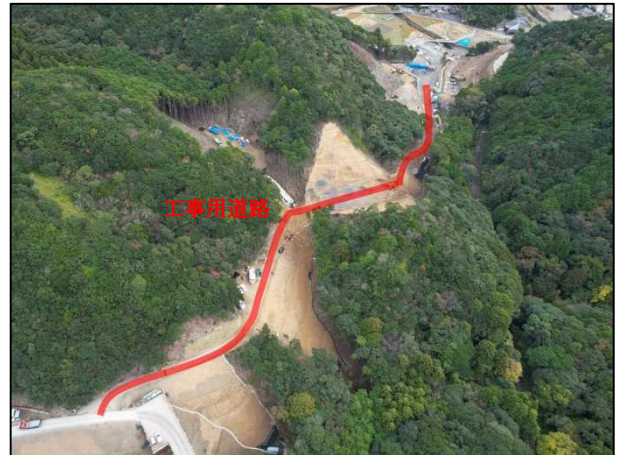
写真 1 工事用道路全景 (赤線：工事用道路)
